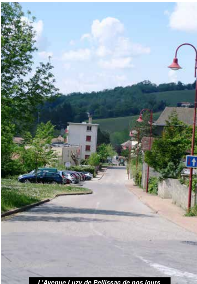
L'Avenue Luzy de Pellissac de nos jours, depuis les travaux de 2009
