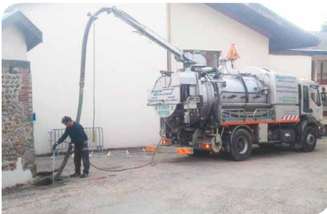
◀ Le processus de curage haute pression sert à décoller les déchets accumulés sur les parois, (graisse, tartre, calcaire, racines..) avant qu'ils obstruent le passage, jusqu'au bouchage complet de la canalisation.
