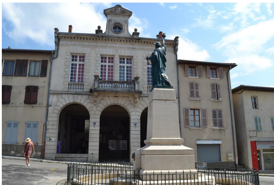
Roybon (Isère), Place Saint-Romme, état actuel.
